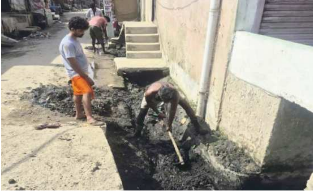
नालों की वृहद स्तर पर सफाई कराई जा रही है। अगर नालों की सफाई समय पर हो जाएगी, तो पानी की निकासी सुचारू
