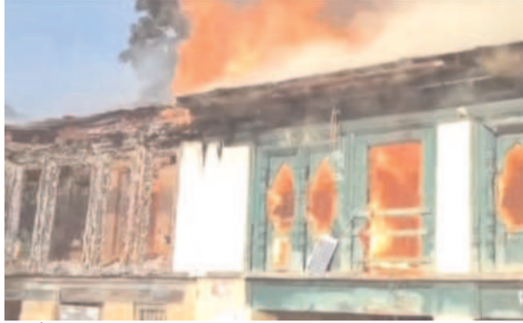
ने फौजर फायर स्टेशन लोहाघाट और राजस्व विभाग को घटना की जानकारी दी। फायर स्टेशन प्रभारी हंस दास सागर के नेतृत्व में दमकल टीम मौके पर पहुंची और ग्रामीणों के सहयोग से करीब घंटे की कड़ी मशकत के बाद आग पर काबू पाया जा सका। हालांकि तब तक भवन पूरी तरह जल चुका था। पूर्व प्रधान ललित मोहन जोशी के अनुसार आग से दोनों परिवारों को लाखों रुपये का नुकसान हुआ है। केवल कुछ सामान ही ग्रामीणों और फायर टीम की तत्परता से सुरक्षित निकाला जा सका। राजस्व निरीक्षक राजेंद्र
