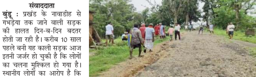
जनप्रतिनिधियों ने इस सड़क की ओर ध्यान दिया। मौनसून में सड़क का कालीकरण पूरी तरह उखड़ गया है, जगह-जगह गहरे
