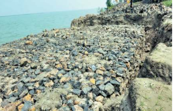
है। वह इतना कमजोर है कि बोल्डर्स आसानी से बाहर निकल जा रहे हैं जिससे कटाव का खतरा ज्यों का त्यों बना हुआ है। बल्कि कुछ स्थानों पर तो और बढ़ गया है। ग्रामीणों ने मौके पर ही अधिकारियों से इन गति का सामग्रियों को तुरंत बदलने की मांग की।
